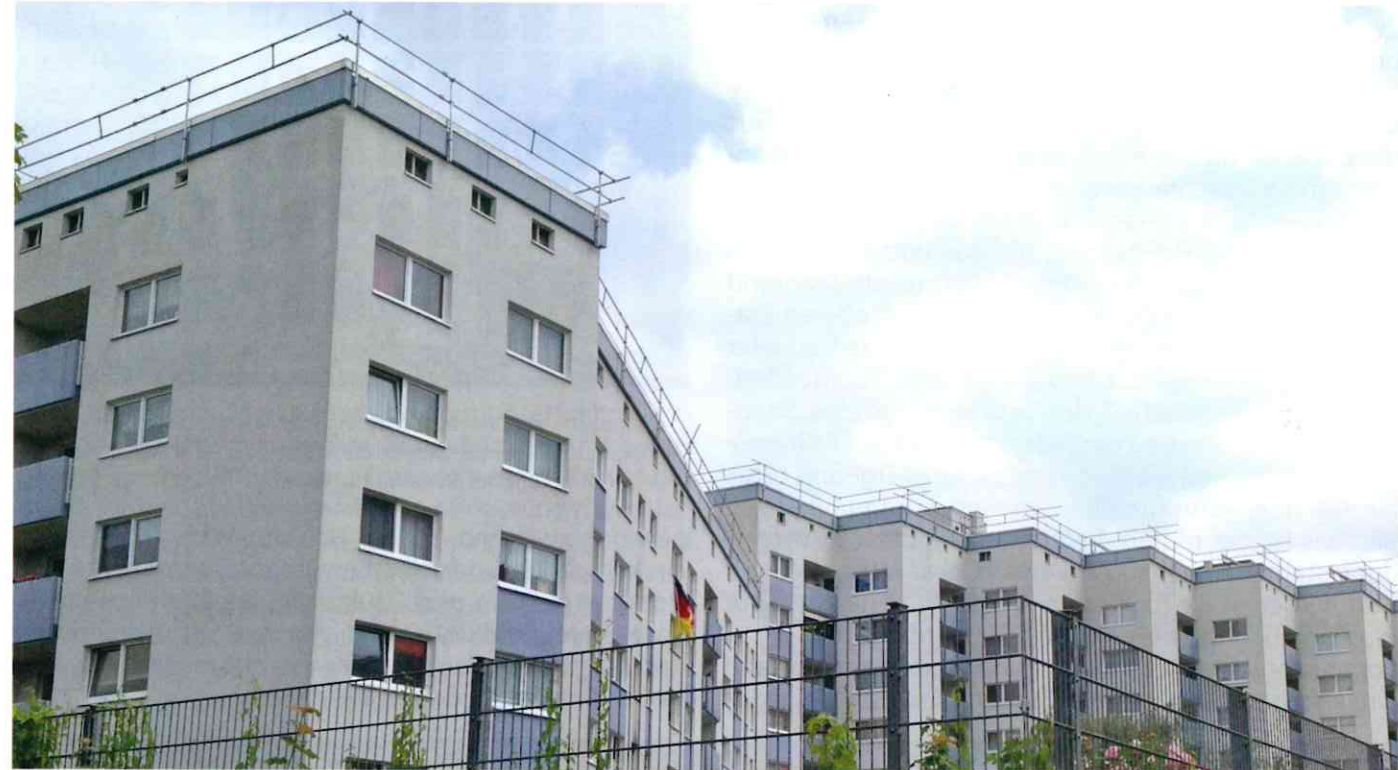
Das Seitenschutz- und Geländersystem gewährleistet barrierefreies Arbeiten auf der gesamten Dachfläche.
