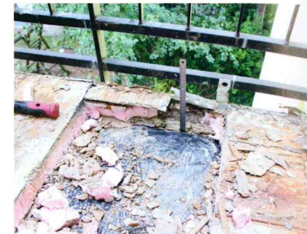
Die Entwässerung der Bitutheneabdichtung hinter das WDS stirnseitig des Balkons.
